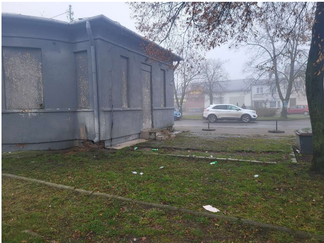
Rycina 12. Teren po dawnej stacji Orlen w Grabowie. Źródło: opracowanie własne.
