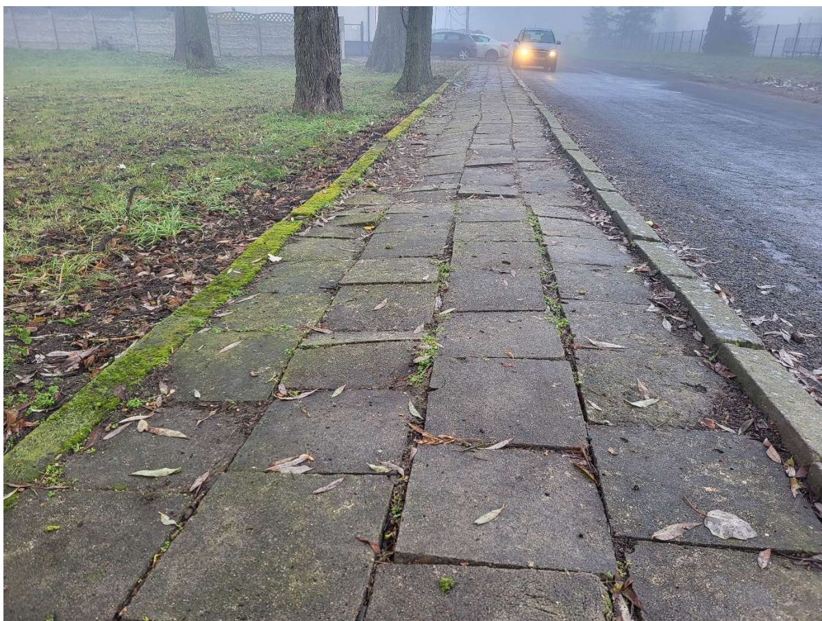
Rycina 6. Stan infrastruktury pieszej przy ul. Parkowej w obszarze rewitalizacji Grabów. Źródło: opracowanie własne.
